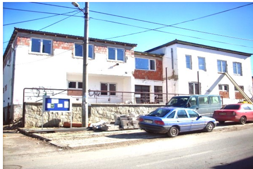
Polyfunkčné centrum Dubovica
