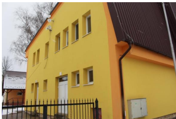
Zateplenie a obnova strechy
